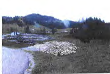
Vue de la parcelle depuis le nord-ouest. Les terrassements avaient débuté. Cliché P. Collin
